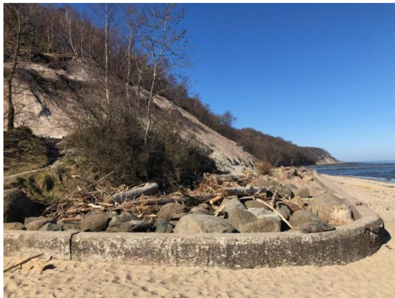
Рисунок 1.4 – Участок 1 – Активный береговой склон с проявлением оползнево-осыпных процессов. На валунах – древесный мусор – следы экстремального волнения
