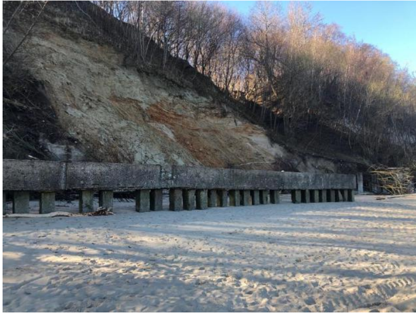
Рисунок 1.10 – Участок 3 – Активный береговой уступ на участке разрушения опояски
