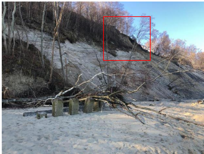
Рисунок 1.7 – Участок 2 – Активный абразионный уступ и разрушенное строение
