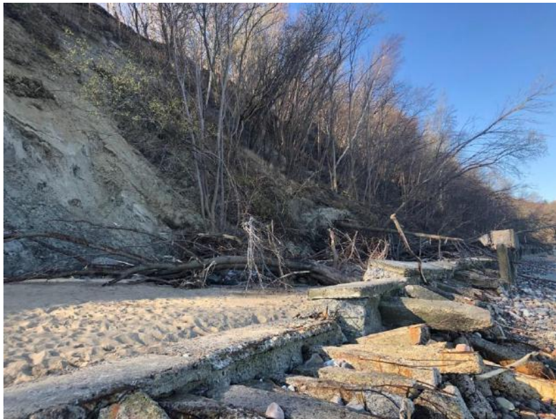
Рисунок 1.11 – Участок 3 – Активный береговой уступ на участке разрушения опояски
