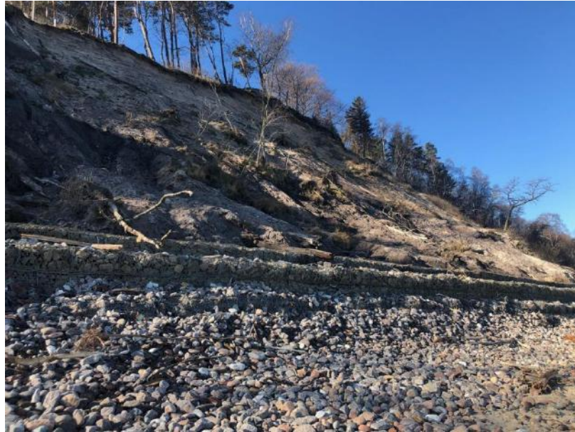
Рисунок 1.14 – Участок 4 – Проявление экзогенных процессов на абразионном уступе Габионы частично разрушены волновым воздействием (рисунки 1.15-1.16 ).
