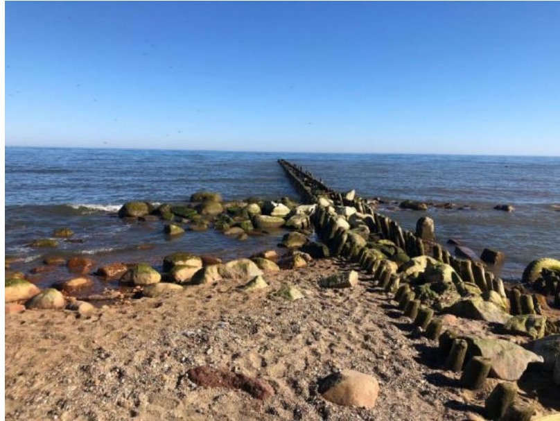
Рисунок 1.3 – Участок 1 – Двурядные буны с валунным заполнением. В основании разнозернистый песок с галькой и гравием
