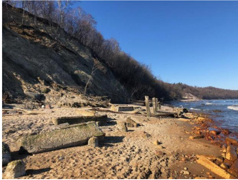
Рисунок 1.12 – Участок 3 – Активный береговой уступ на участке разрушения опояски
