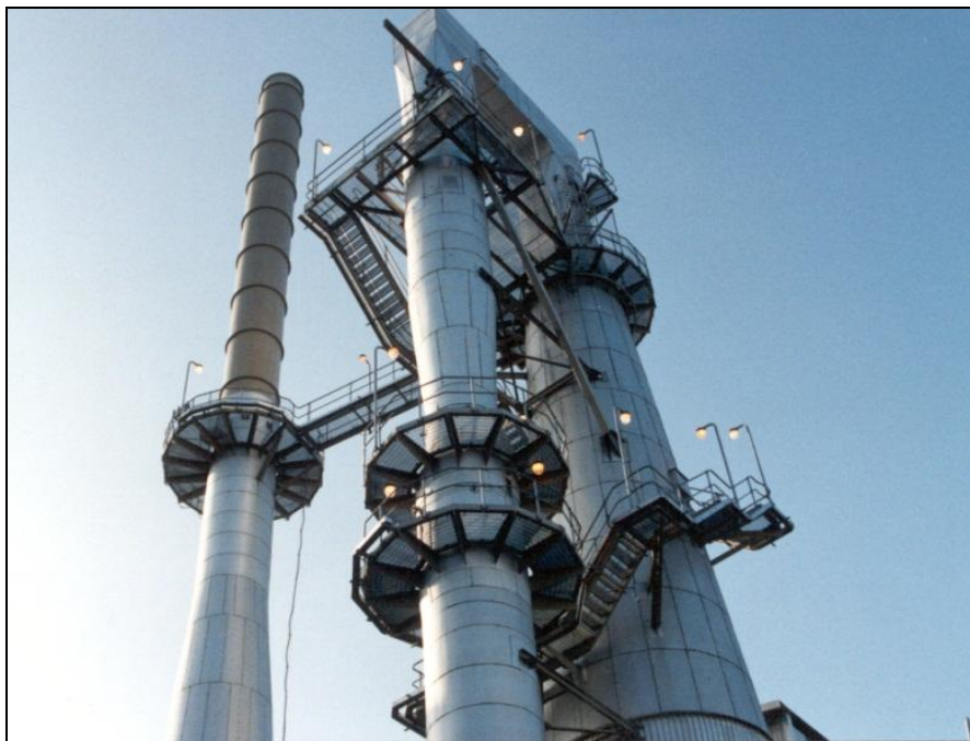
Рисунок 6.2.1.1-2. Охладитель ГОУ печей обжига анодов
